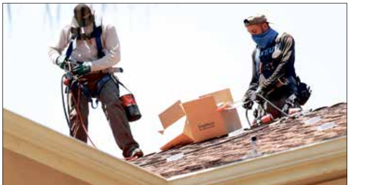
عمليات تركيب ألواح طاقة شمسية في مزارع ولاية كاليفورنيا (Getty)
